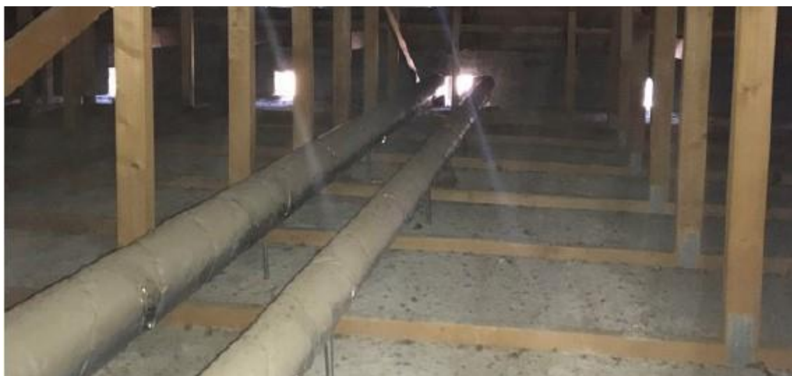
Abbildung 15: Bestehender Dachraum im Bauteil A Schule
