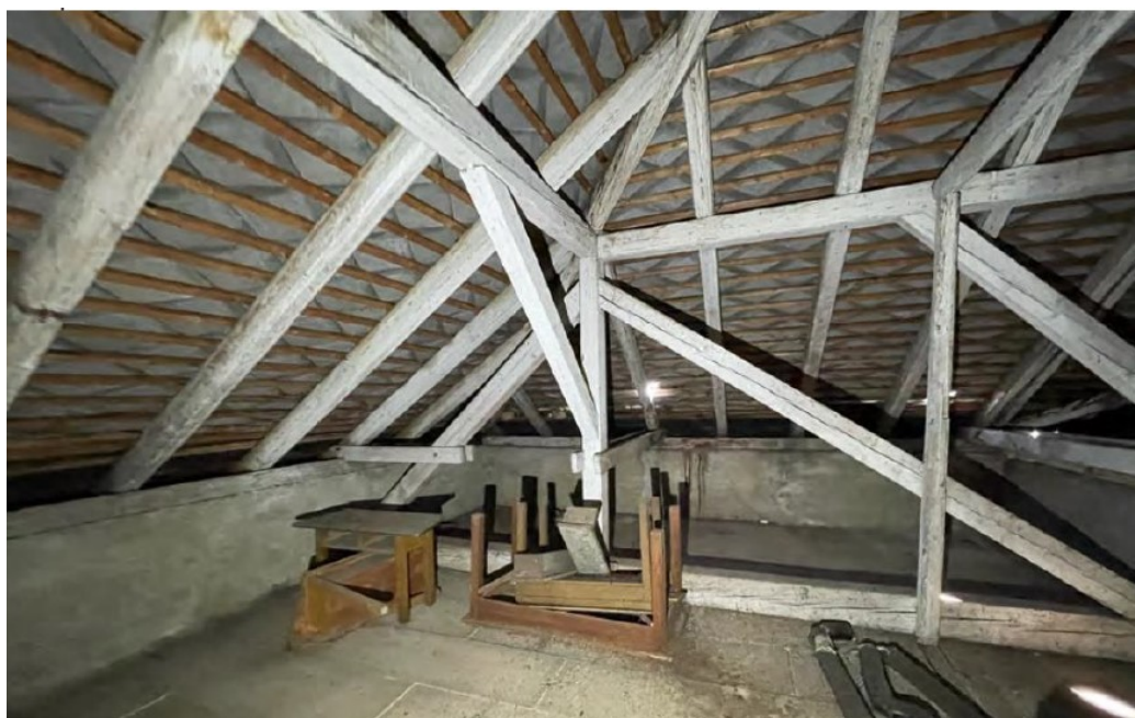
Abbildung 16: Foto des Dachstuhls
