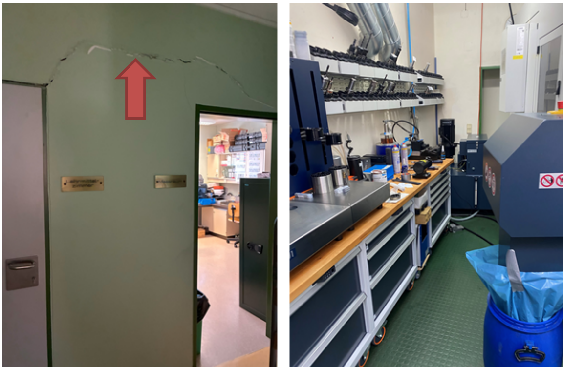
Abbildung 2: Gebäudezustand und Platzverhältnisse
