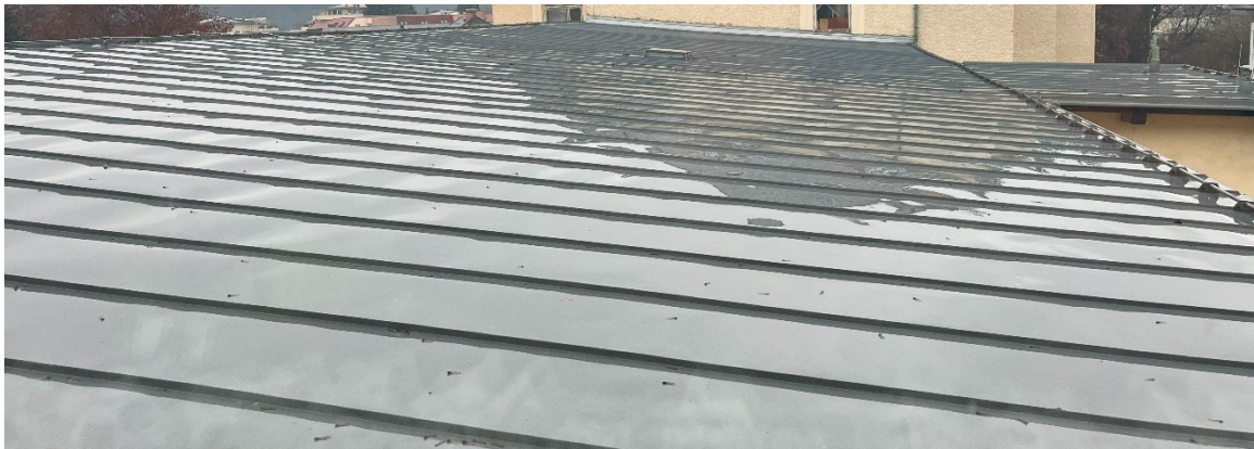
Abbildung 4: Dachdeckung bestehendes Pultdach
